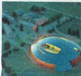
Le bâtiment, vu du ciel, tel qu'il se présentera de nuit. DR
