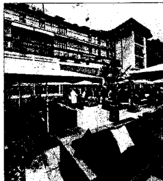
Le Mirador Kempinski a rouvert début juillet après dix mois de travaux pour un investissement de 50 millions de francs.
